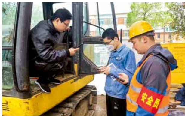
4月19日，区生态局监测中心工作人员对惠州里管网施工工地非道路移动机械尾气排放进行监测（朱彬摄）
